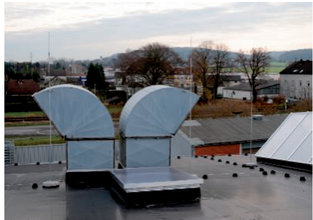
Gescheiden systeem met GFK-houders
