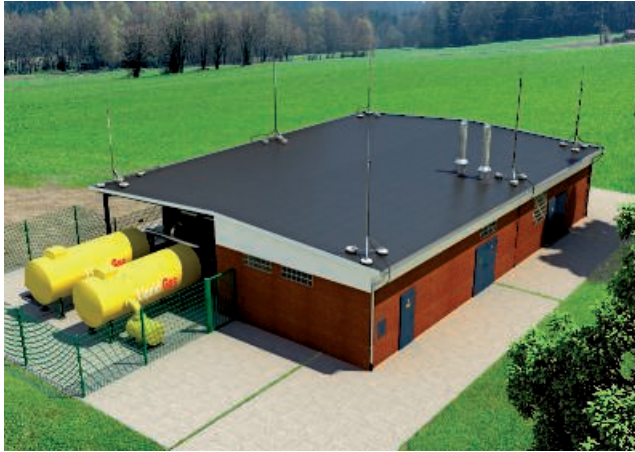
isCon®-afleiding op vangmast in Ex-omgeving
