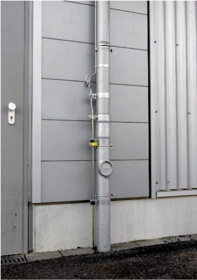
Bliksembeveiligingsafleiding op een regenpijp
