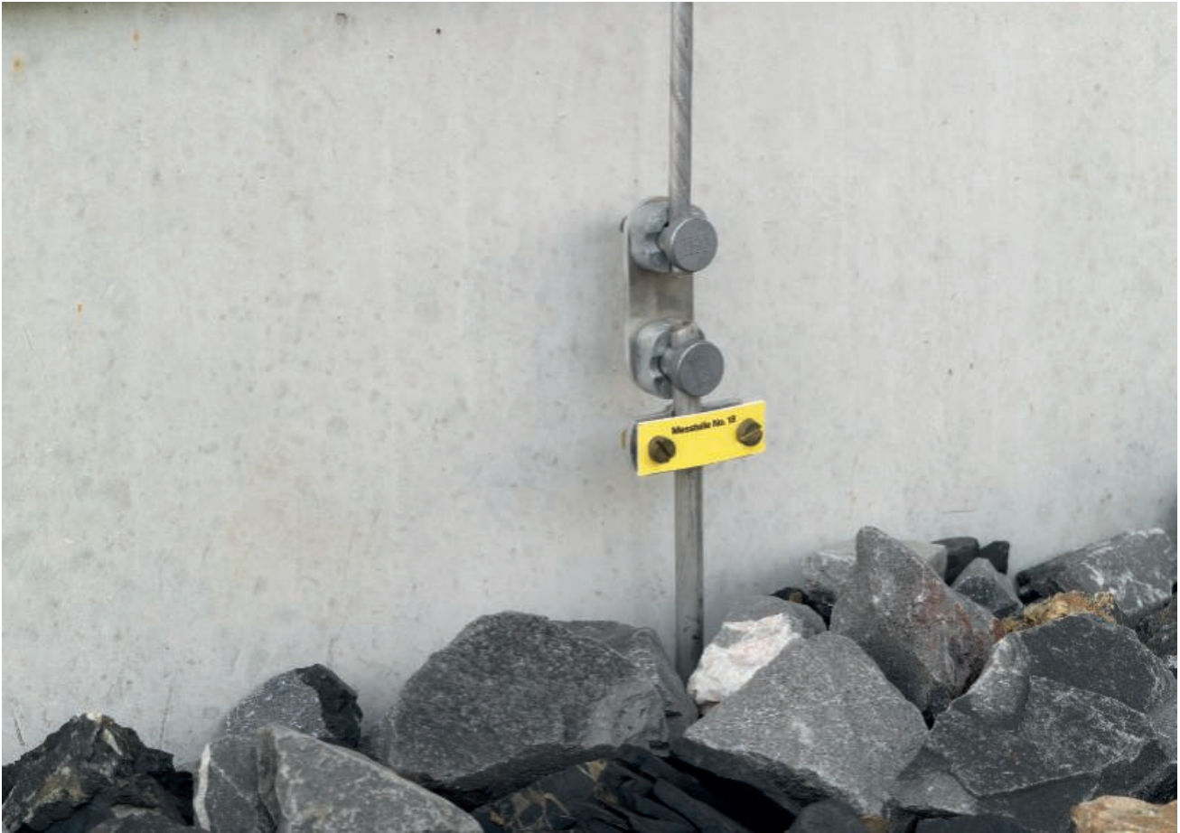
Scheidingspunt op een metalen gevel
