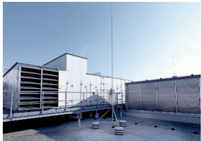
Geïsoleerde bliksembeveiliging met isFang
